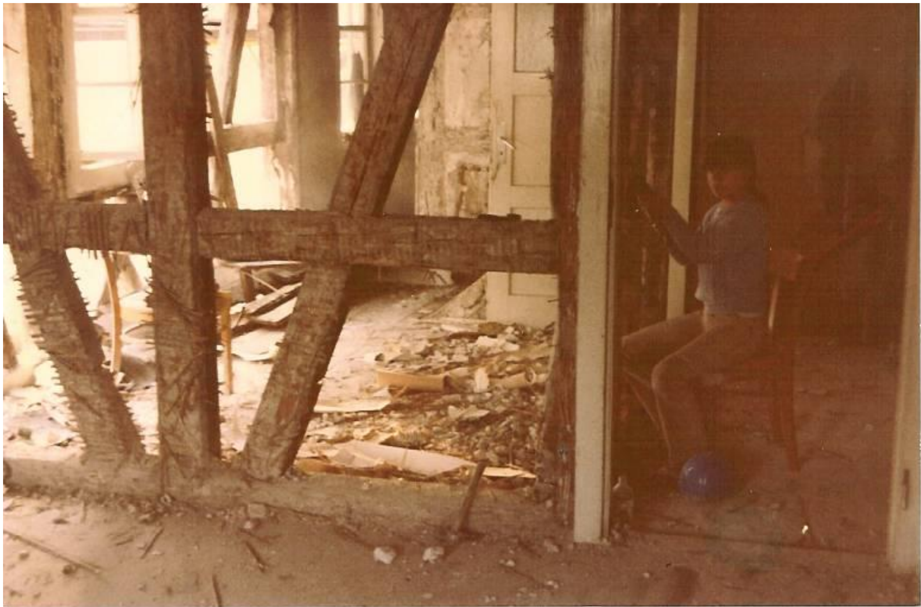
Annette beseitigt Reste der Strohmatte von den Balken.
