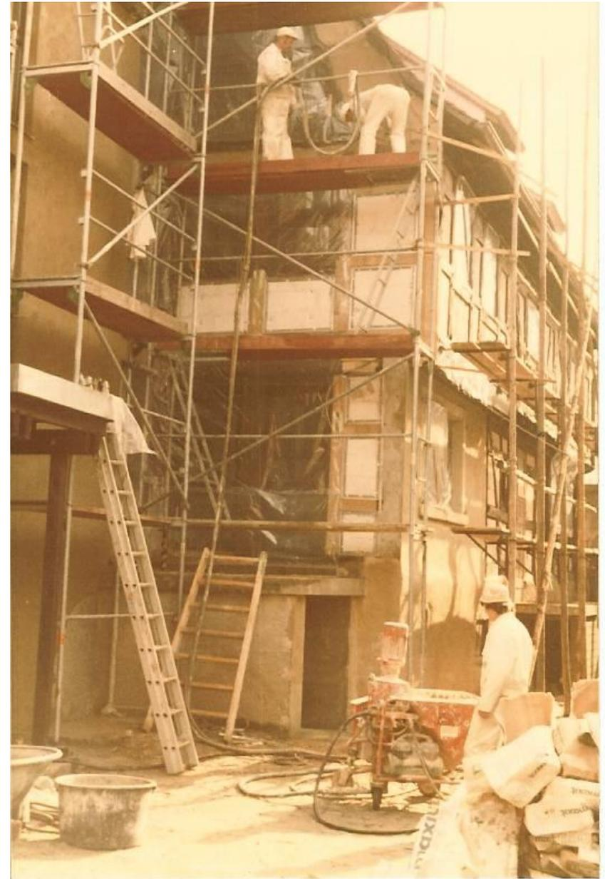
**Die Balken mussten mühsam abgeklebt werden, damit sie nicht durch das Putzmaterial verschmiert werden.**
